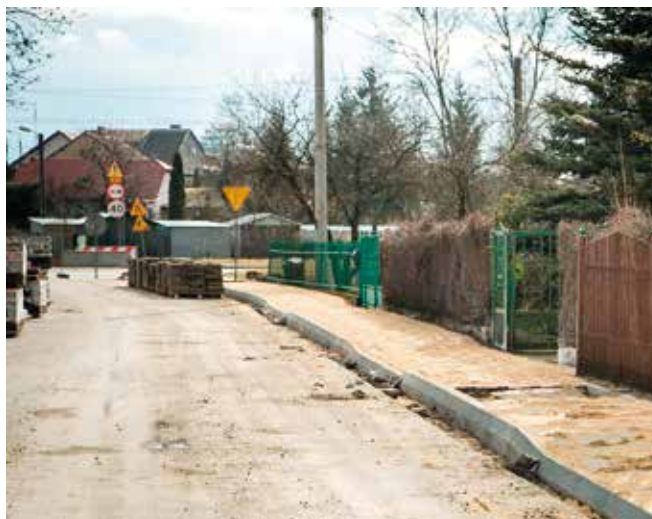
Remont ul. Staszica w Przystusze.
