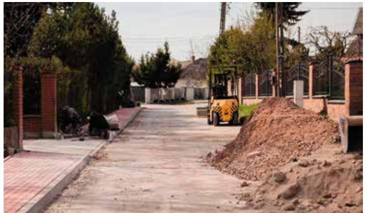
Roboty drogowe na ul. Świętokrzyskiej w Przysusze.
